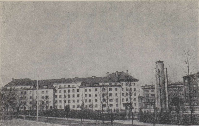
Фото 3. Жилой дом по ул. Янсени, 3.
