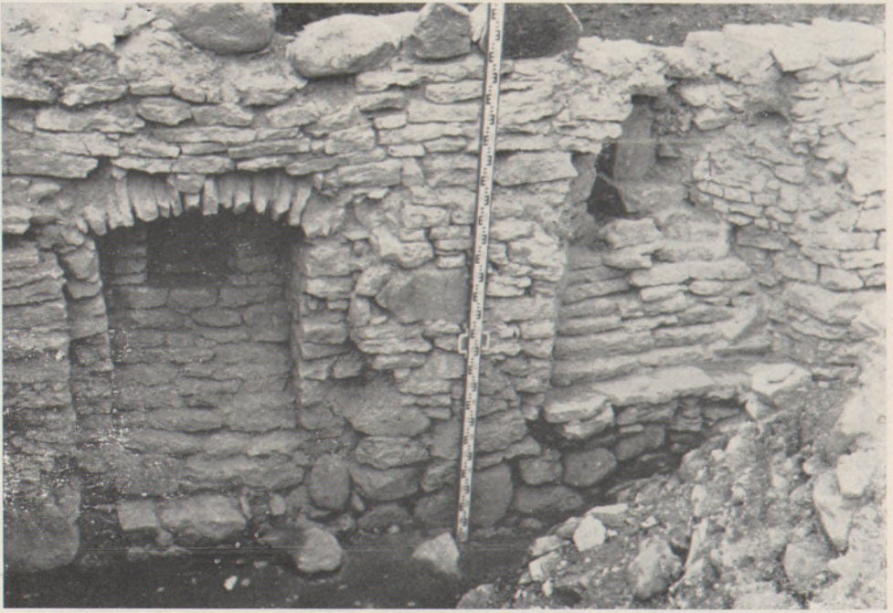
1. Haapsalu, Jaani-Straße. Lichtluken des Raumes Nr. 3, von Süden gesehen.
