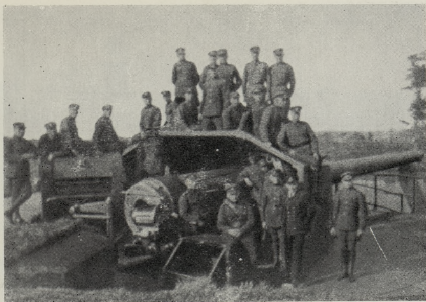
1. 9,2-tolline kahur Suurupis 1920. aastate algul. Vasakul eekterseadis laskemoona tõstmiseks alt varjendist suurtüki juurde.
