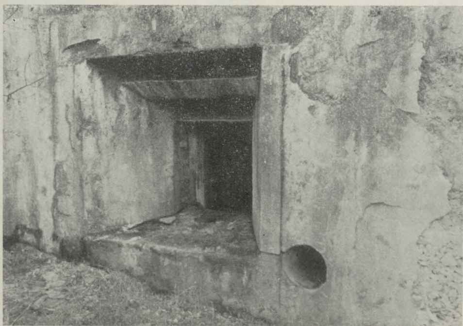
Aken ja õhutusava betoonblindaaži esiseinas. Välisava laius 1,5 ja kõrgus 1,4 m. H. Gustavsoni foto 1983.
