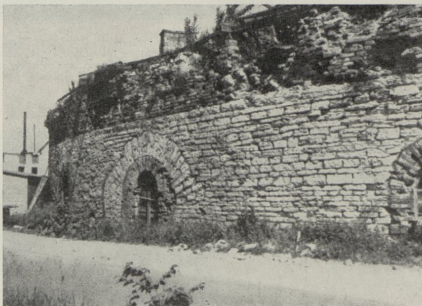
Vaade Kaitsekasarmu mortiiripatarei frontaalküljele 1987. aastal. Näha osaliselt kinnimüüritud suurtükilaskeavad ja Krimmi sõja päevil peale ehitatud kaitsekorruse säilmed. (Foto H. Gustavson.)
