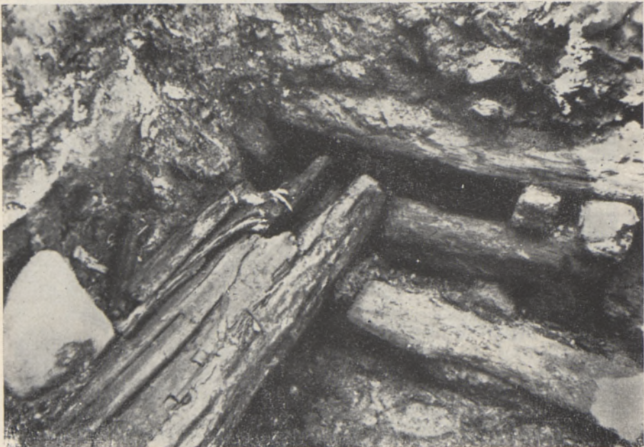
2. Tartu, Trasse I. Brunnen mit der Balkeneinfassung und den Holzrinnen.
