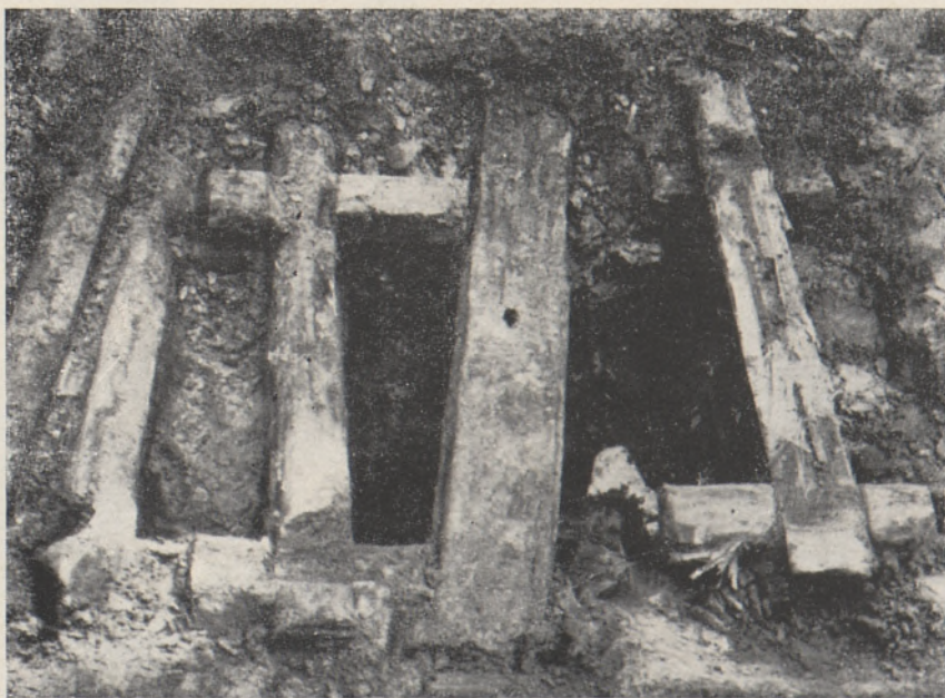
2. Tartu, Trasse III. Brunnen mit der Holzeinfassung.
