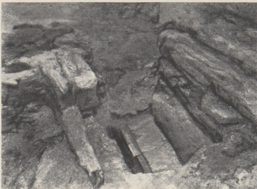
1. Tartu, Trasse I. Mit der Birkenrinde bedecktes Kanalisationsrohr.
