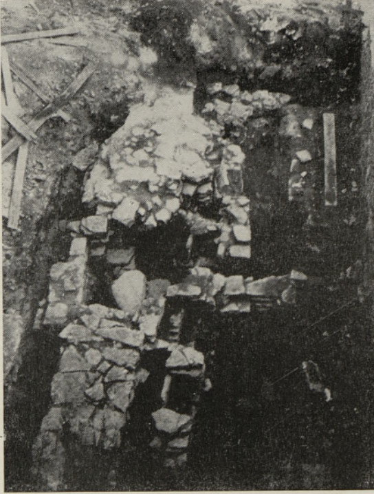
1. Überreste des Halbkellergeschosses eines Gebäudes auf dem Territorium des mittelalterlichen Marstalles von Tallinn.
