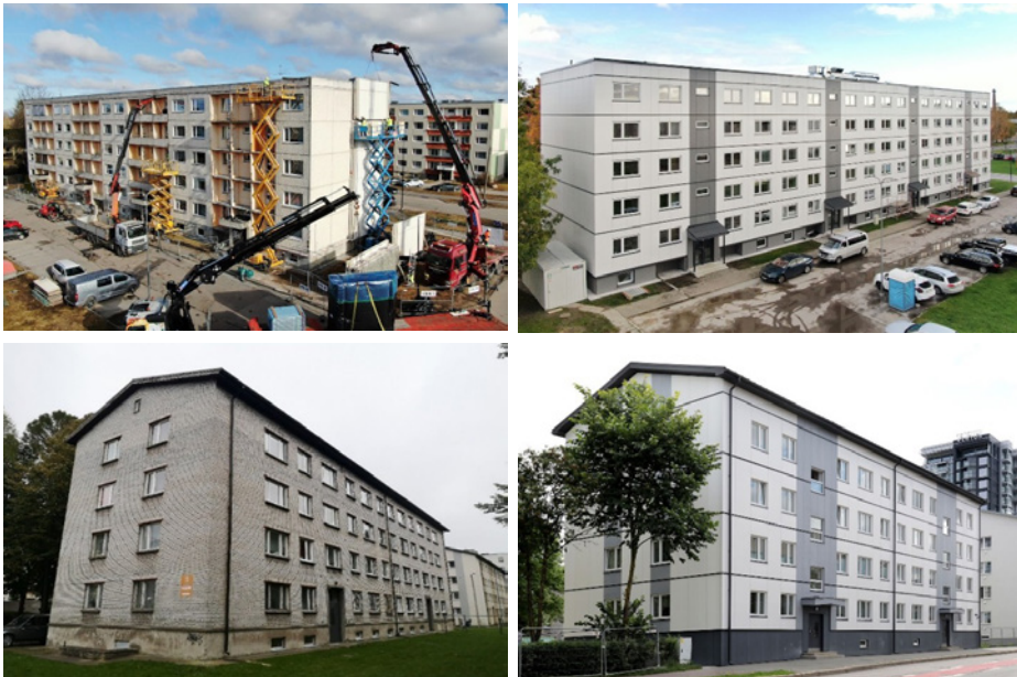
Joonis 10. Tüüpseeria 111-121 (ülal) ja 1-317 (all) korterelamud enne (vasakul) ja pärast (paremal) renoveerimist.
