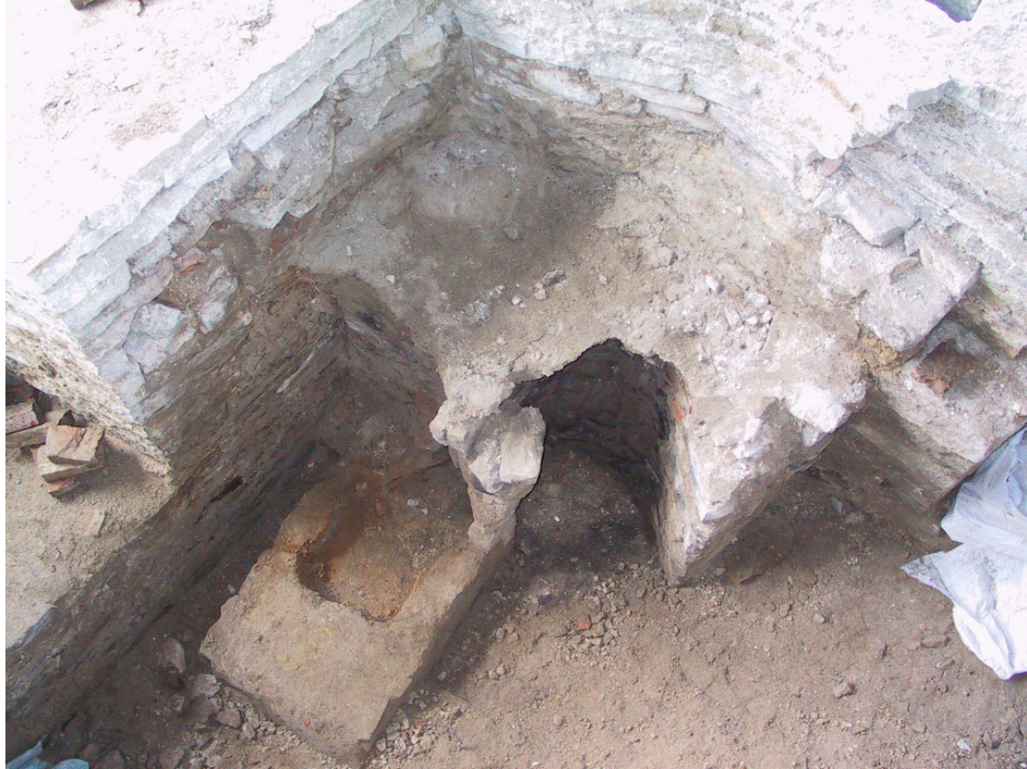
Joon 3. Maasi linnus. Mantelkorstnaga ruumi rajatud kahhelahju alus (vasakul) ühes kaminaga. Jagatud kütteruum lubab oletada, et mõlemad on ehitatud üheaegselt. Foto Tõnu Sepp.
